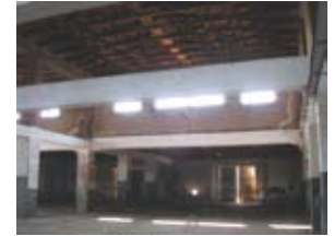
Hörsaalgebäude vor dem Umbau
